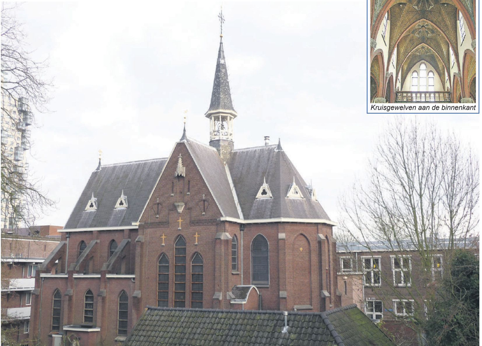
Dakconstructie en zij-aanzicht van de Ursulinenkapel. Let op het middenschip en het zadeldak.
