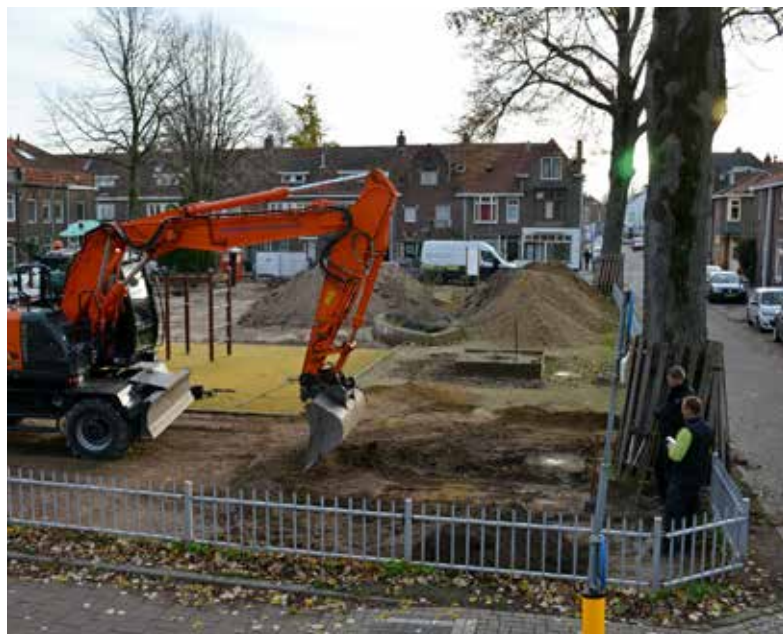
Toezicht bij graafwerkzaamheden aan het Lindeplein
