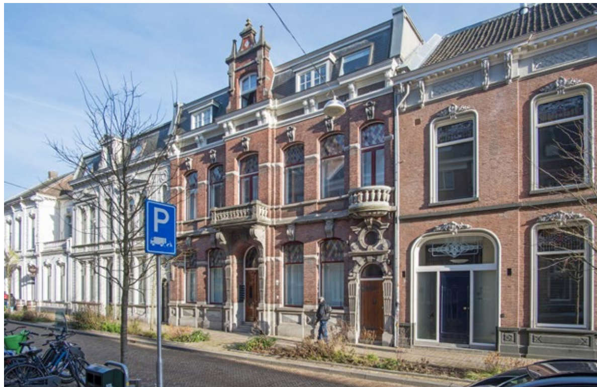
Prachtige gevel aan de Stationsstraat 32.
